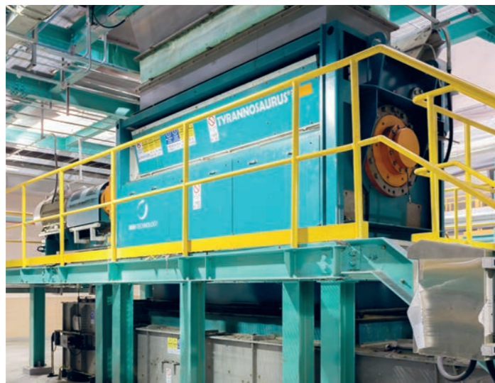
← Các cửa lớn, cửa sập đảm bảo tiếp cận máy cắt dễ dàng.
